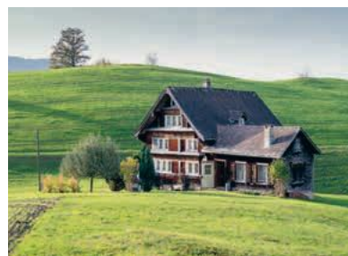
Anbau Sticklokal mit grossen Fenstern / Blomberg, Ebnat-Kappel.
