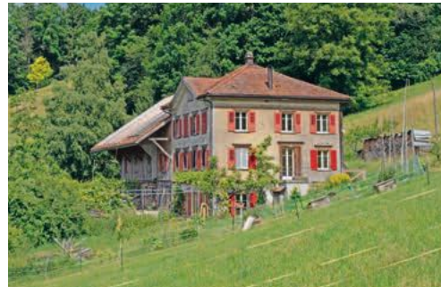
Bauernhaus mit Stickereilokal im Sockelgeschoss und Scheunenanbau / Letten, Kirchberg
