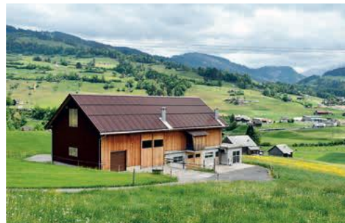
Mittelgrosse Scheune mit Anbindestall, Milchraum, Tenn, Futterlager und Remise / Tobel, Nesslau
