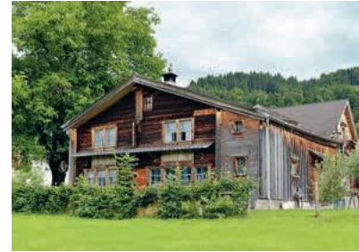
Dieses Wohnhaus mit flach geneigtem Dach ist über 550 Jahre alt und eine der ältesten Holzbauten in der Region / Dorfrand Ennetbühl.
