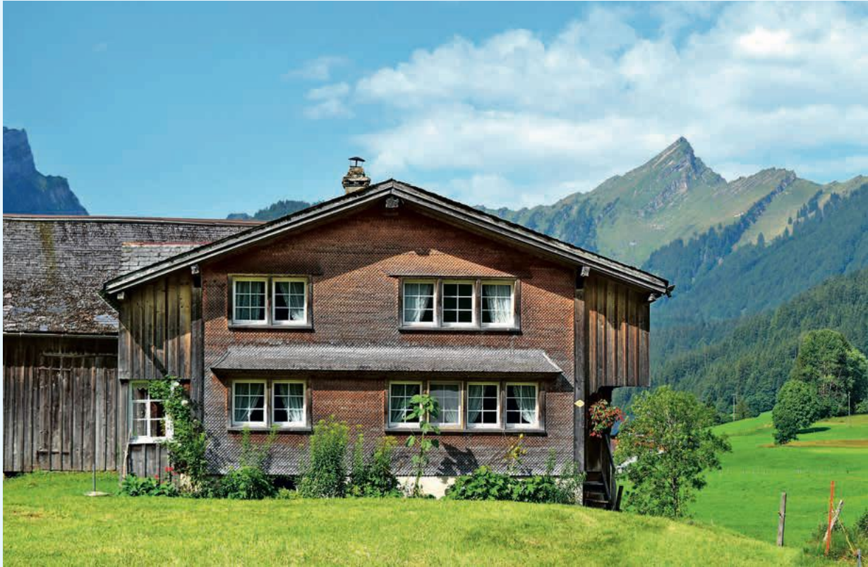
Einfaches Bauernhaus mit flach geneigtem «Tätschdach» und charakteristisch gegliederter Hauptfassade / Brunnen-Laad, Nesslau.
