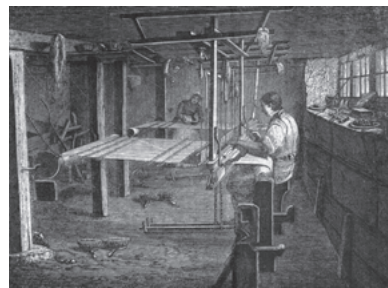
In den Kellern unter der Stube wurden Webstühle eingerichtet. Viele Bauernfamilien waren auf ein zusätzliches Einkommen angewiesen / Ein Webkeller im Toggenburg.
