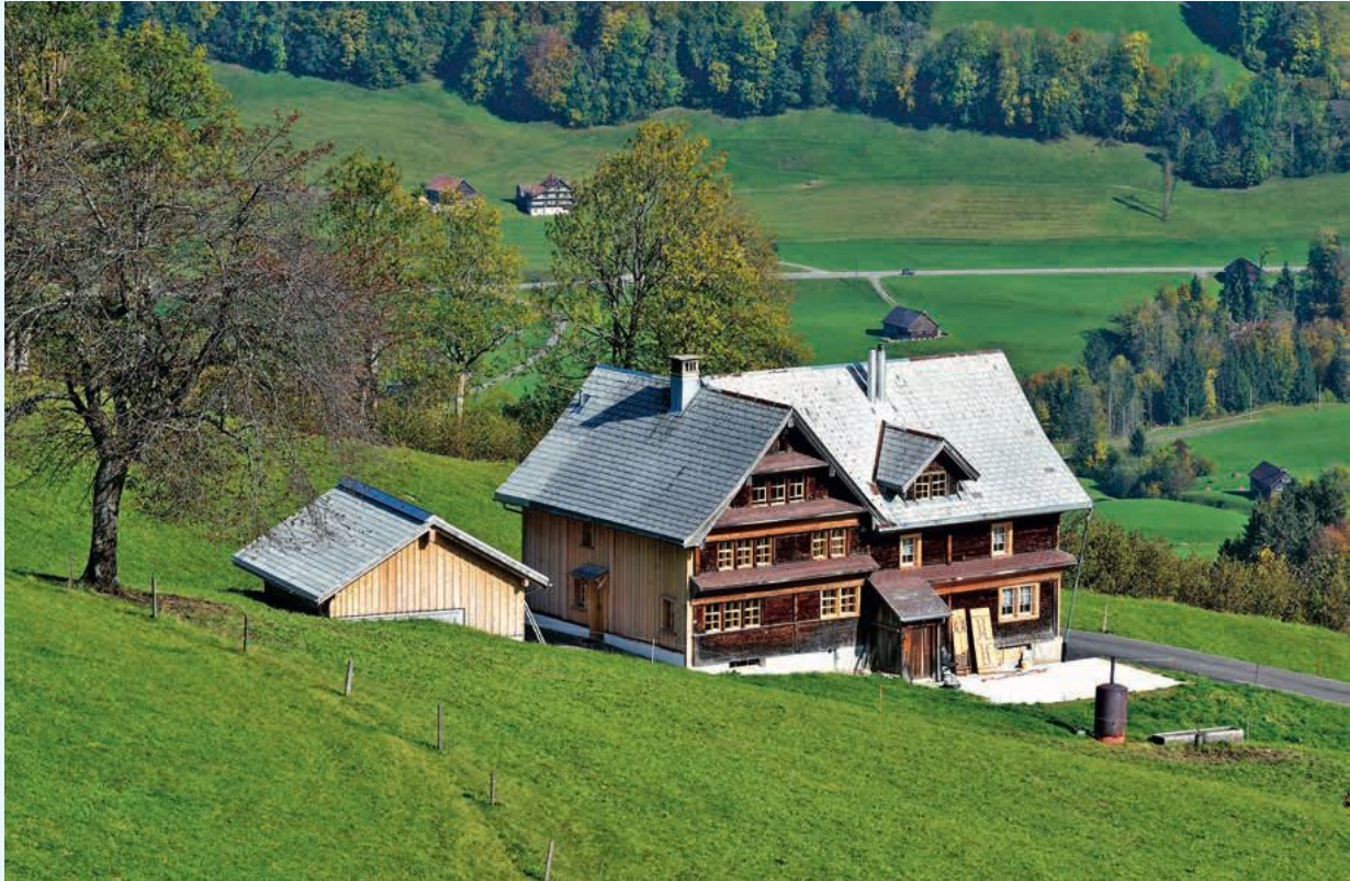
Frisch saniertes Wohnhaus und neue Remise / Chasten-Bühl, Nesslau.
