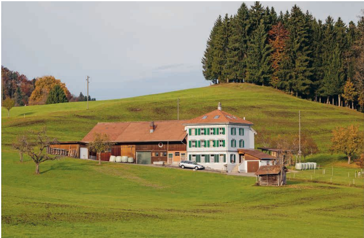
In der bäuerlich geprägten Landschaft des unteren Toggenburgs wurde während der Stickereizeit eine Vielzahl Gebäude erneuert. Im Sockelgeschoss wurden Gewerberäume mit grossen Fenstern erstellt. Beispiel eines sorgfältig sanierten Bauernhauses in Gähwil / Egg, Kirchberg.
