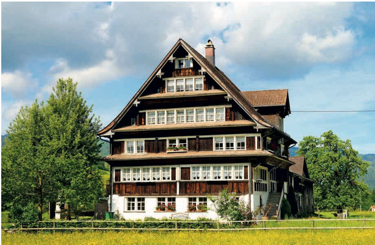
Stättliches Steilfirsthaus mit grosser Firstkammer im ersten Dachgeschoss. 1781 vom Orgelbauer Joseph Looser errichtet / Lüpfertwil, Ebnet-Kappel.
