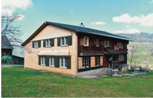
Bauernhaus mit Tätschdach und nachträglich eingebautem Sticklockal / Richelschwand, Nesslau
